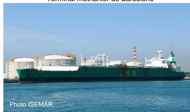
Terminal méthanier de Barcelone
